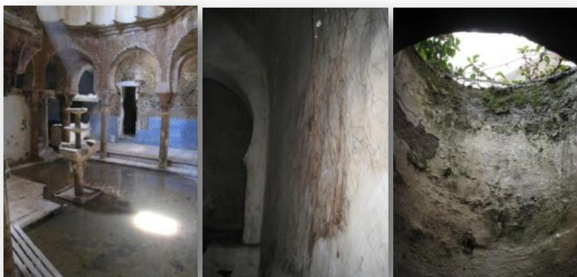
Figure 4 : Quelques vues sur les espaces du hammam
