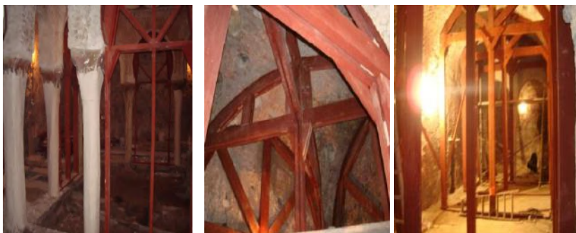
Figure 6 : Travaux d'urgence avec mise en place des étaieiments
