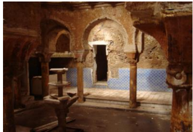
Figure 3 : Vue sur le patio et galerie du Hammam Es-sebaghine
