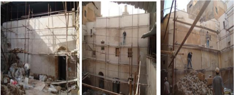
Figure 7 : Travaux de ravalement de façades
