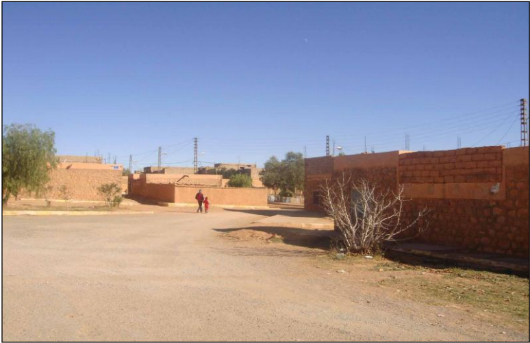
Figure 3 : Village de Mogheul, substitution totale au ksar (wilaya de Béchar, 2012)
