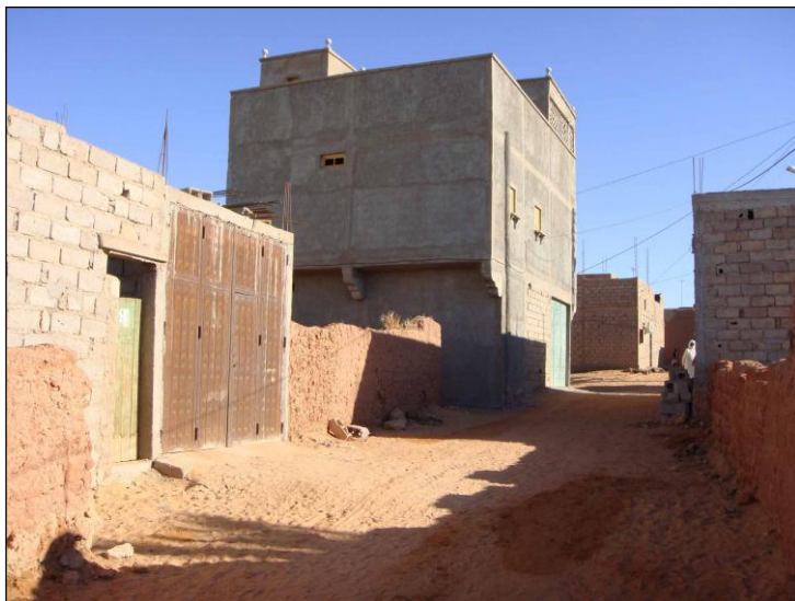
Figure 2 : Transformation du bâti au ksar de Tilouline, commune d'Inzeghmir, wilaya d'Adrar (2011)
