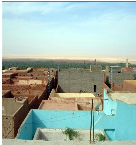
Figure 9 : Le ksar de Tilouline presque complètement transformé
