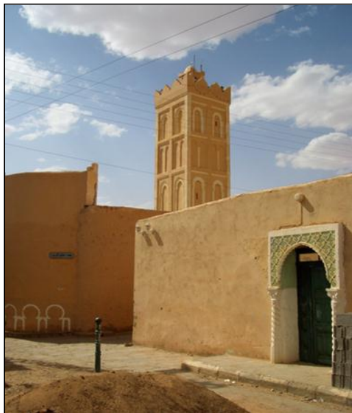
Figure 7 : L'entrée du ksar de Kenadsa en partie restauré
