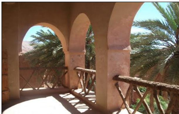
Figure 6 : Une partie du ksar de Boussemgoun après restauration
