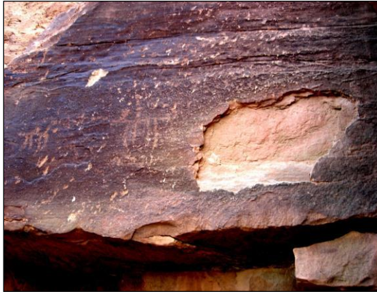
Figure 7 : Exemple de desquamation de la roche
